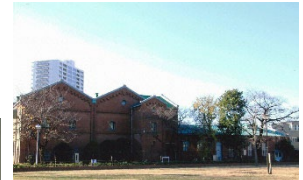
重要文化財： 旧醸造試験場 第一工場
