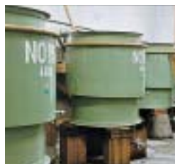
開放型発酵タンク
