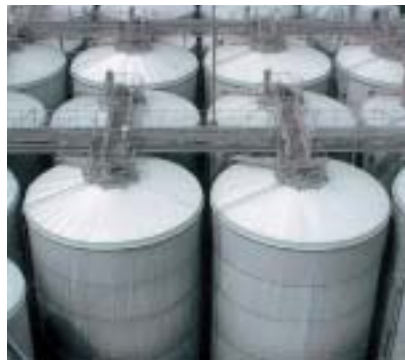
アルコール発酵を行う大容量のタンク群
